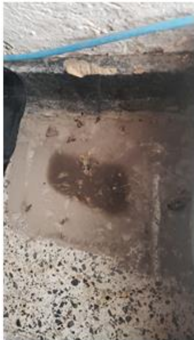
Manchas de humedad en pisos y paredes tras las reiteradas inundaciones
