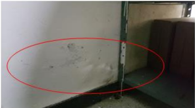
Filtración de humedad en techos y paredes
