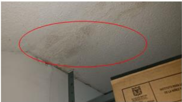
Filtración de humedad en techos y paredes
