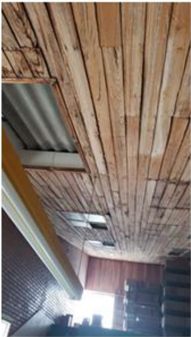
Manchas de humedad en pisos y paredes tras las reiteradas inundaciones
