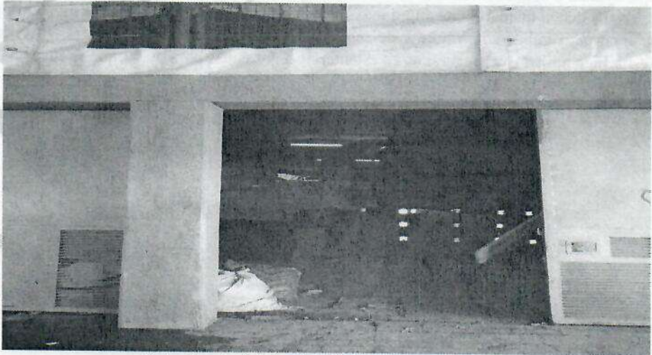
Entrada a la Sub-bodega de Av. 68 con Calle 13
