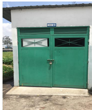
Falta de estibas y de protección en la puerta que eviten el acceso de plagas – UPI Arcadia
