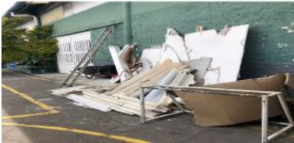
Imagen 120. Escombros del taller de ebanistería
