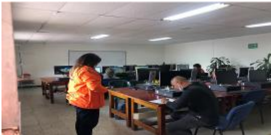
Imagen 114. Techo de la sala de cómputo dañado
