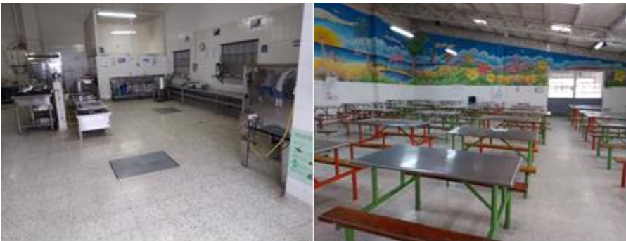
Imágenes 138 y 139 Estado de las instalaciones de la cocina y el comedor al inicio de las actividades
