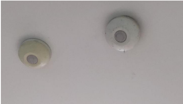
Imagen No. 47. Upi La Florida Bodega 1 detectores de humo inservibles
